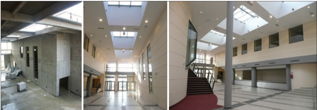
15. Hol główny. Świetliki. Wybrane materiały z pierwszego (2006–2008 r.) i drugiego (2010–2012 r.) etapu realizacji kampusu A. PPIp. Fot. własne 15. The main hall. Rooflights. Selected materials from the first (2006–2008) and second (2010–2012) stage of the campus building. PPIp. Private photo
