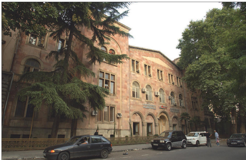
24. Tbilisi, fasada Zarządu Dróg Kolejowych Zakaukazia, 1926-1927. Proj. Henryk Hryniewski. Fot. Autor, 2010 r. 24. Tbilisi, façade Transcaucasian Railway Road Administration building, 1926-1927. Designed by Henryk Hryniewski. Photo Author, 2010
