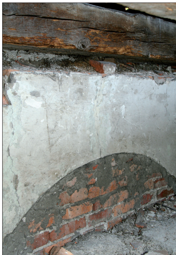
9. Bóżnica w Fordonie, wnętrze, ślad otworu drzwiowego babinca, 2008 r.; fot. A. Jankowski
