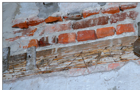
10. Bóżnica w Fordonie, wnętrze, ściana pn. pierwotnej sali modlitw, widoczna belka podciągu dawnej empy, 2008; fot. A. Jankowski
