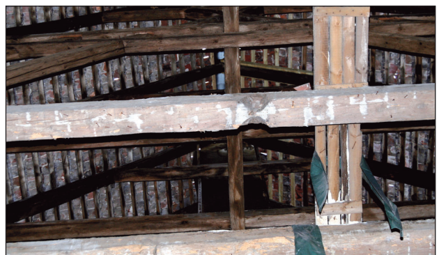
14. Bóżnica w Fordonie, wrąb w belce wiązarowej – ślad połączenia z konstrukcją bimy, 2008 r.; fot. A. Jankowski 14. The synagogue in Fordon, the truss beam, a north – a trace of a joint with a bimah construction, 2008; photo A. Jankowski
