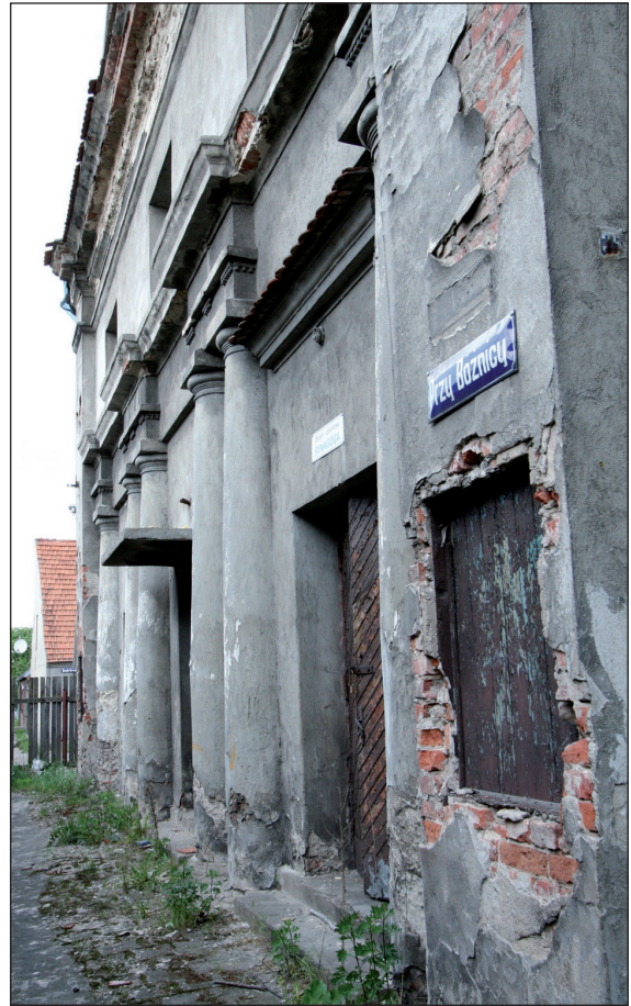
5. Bóżnica w Fordonie, elewacja frontowa, półkolumny pod belkowaniem, 2008 r.; fot. A. Jankowski 5. The synagogue in Fordon, the front elevation, semicolumns under the entablature, 2008; photo A. Jankowski
