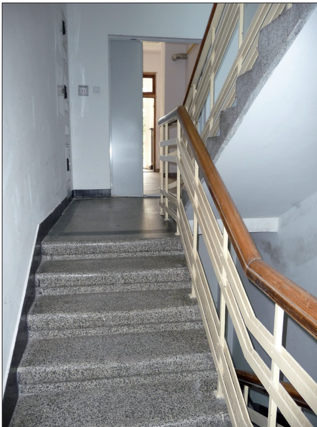
22. Klatka schodowa w budynku przy ul. Cieszyńskiej 3a. Fot. E. Popławska-Bukała, 2010
