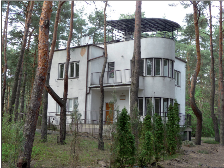
23. Budynek przy ul. Ziemowita 7. Fot. E. Popławska-Bukała, 2010 23. House, 7 Ziemowita Street. Photo: E. Popławska-Bukała, 2010
