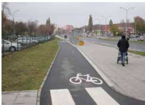
Fot. 4. Warszawa (Polska) – dwukierunkowa ścieżka dla rowerów i chodnik w rejonie przystanku autobusowego oddzielone opaską z wtopionego krawężnika i kostki kamiennej, które wyznaczają powierzchnie przeznaczone dla różnych grup użytkowników
