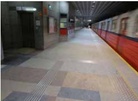
Fot. 7. Warszawa (Polska) – stacja metra Młociny, przykład oznakowania strefy zagrożenia i pól uwagi ścieżki dotykowej
