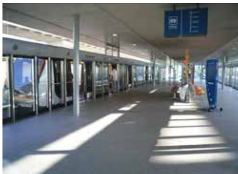
Fot. 11a. i 11b. Port lotniczy Roissy Charles de Gaulle (Francja) i Taipei (Rep. Chińska) – oddzielenie peronu od toru linii metra w formie automatycznie otwieranych i zamykanych drzwi
