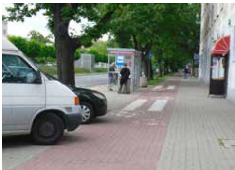
Fot. 3. Warszawa (Polska) – ścieżka rowerowa o nawierzchni z tego samego materiału (kostki brukowej) – obok parkujące samochody. Rozwiązanie nie spełnia standardów bezpieczeństwa i komfortu zarówno pieszych, w tym osób niepełnosprawnych, jak i rowerzystów
