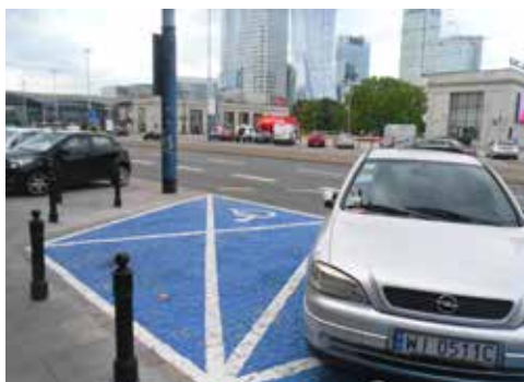
Fot. 6. Stanowiska parkingowe przyuliczne ukośne dla osoby niepełnosprawnej
