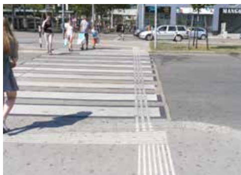
Fot. 2. Wiedeń (Austria) – przejście dla pieszych z oznakowaniem strefy zagrożenia na chodniku oraz ścieżką prowadzącą
