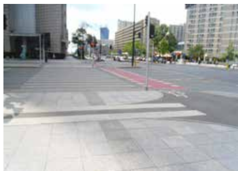
Fot. 1. Przejście dla pieszych z oznakowaniem strefy zagrożenia na chodniku oraz azylu dla pieszych
