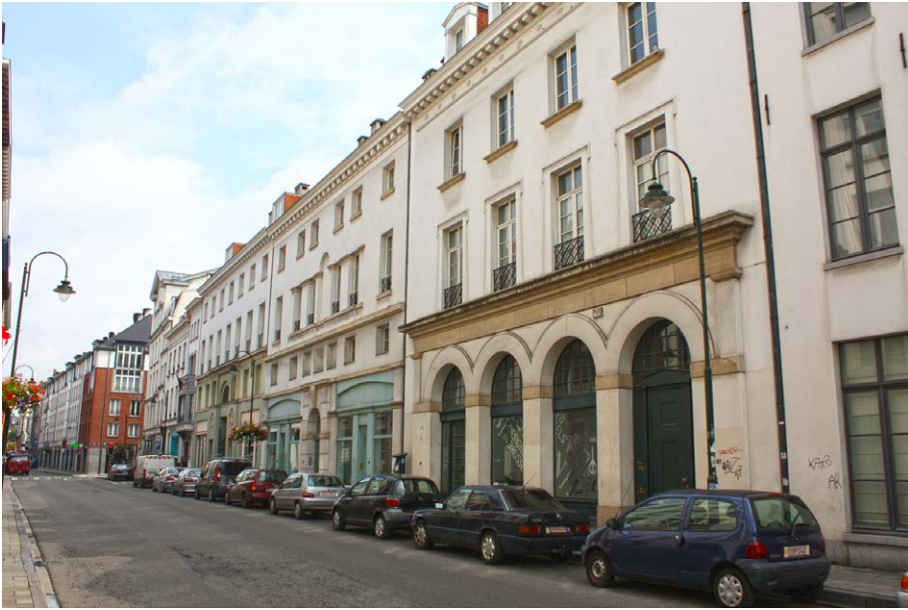
Fot. 4. Rewitalizacja Rue de Laeken w Brukseli, 1989-1995
