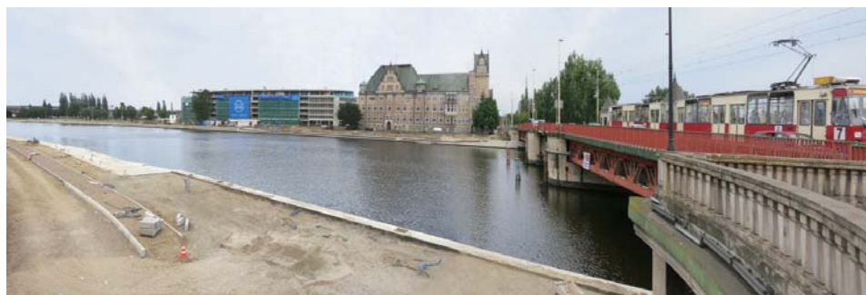
Ryc. 6. Przebudowa nabrzeża przy moście Długim. Na wyspie Łasztownia Izba Celna i nowy biurowiec „Lastadia Office” w budowie (fot. H. Petryshyn, 2012).
