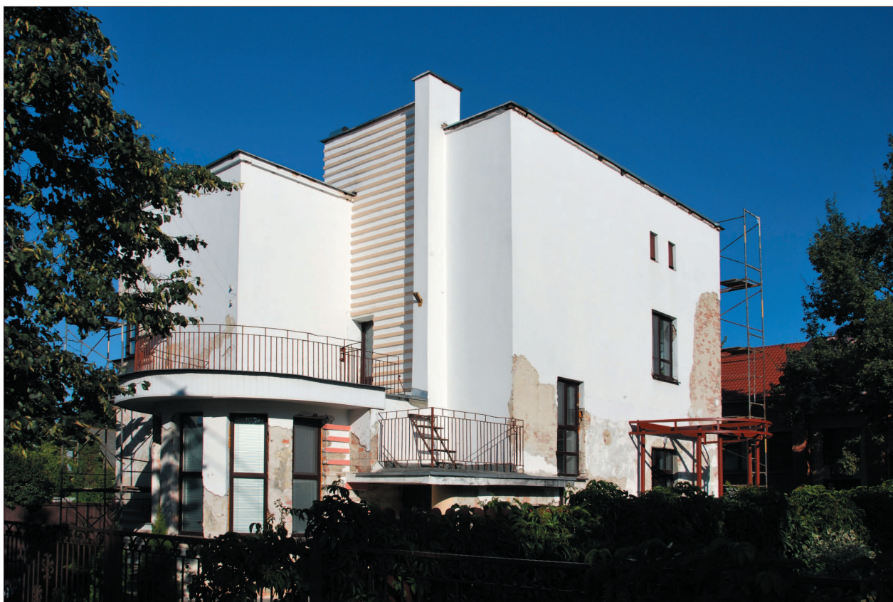
23. Budynek mieszkalny przy ul. Pułaskiego, fot. M. Pszczółkowski, 2013 23. Residential building on Pulaski Street, photo by M. Pszczółkowski, 2013
