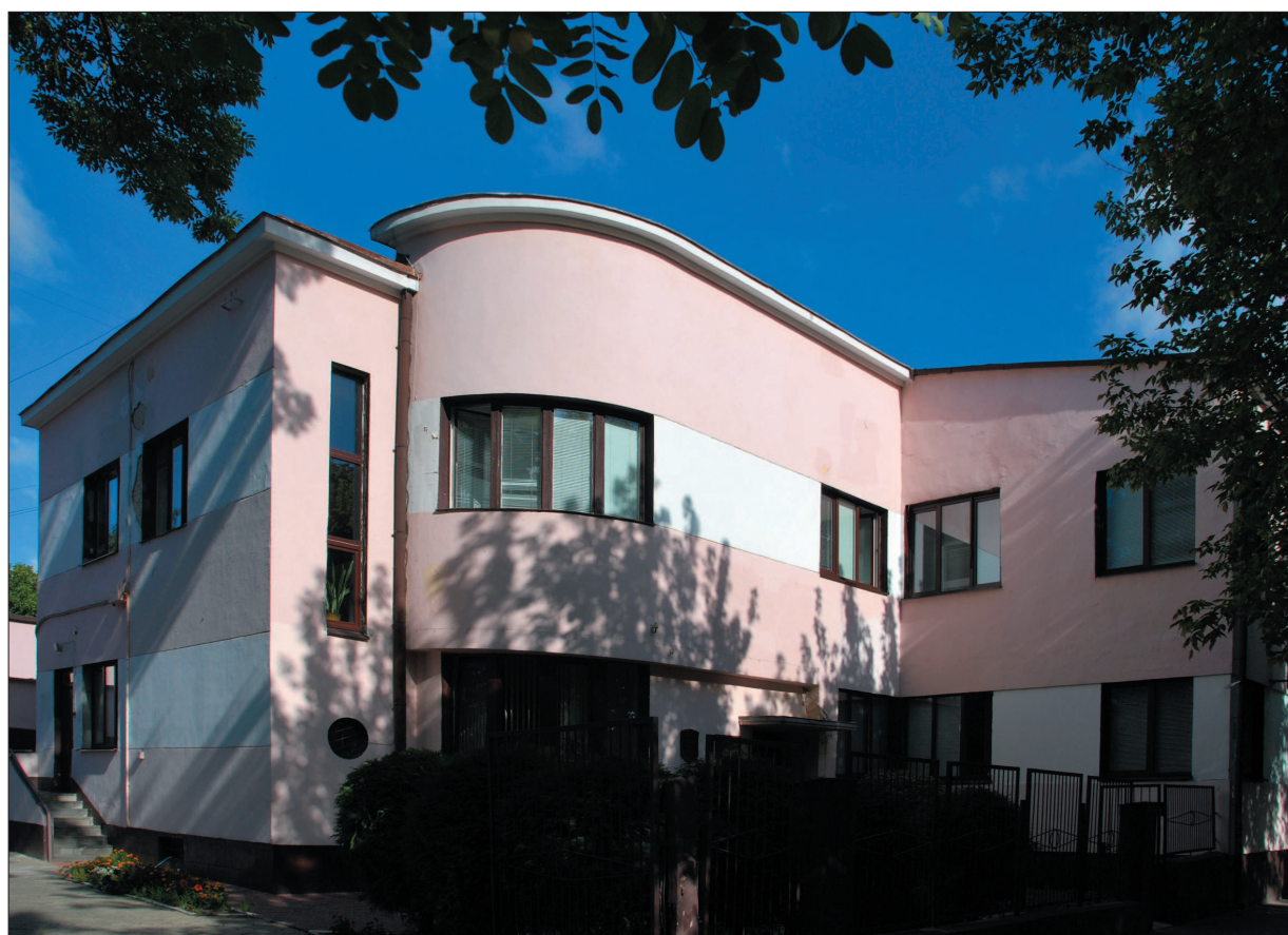
26. Budynek mieszkalny przy pl. Wolności, fot. M. Pszczółkowski, 2013 26. Residential building on Freedom Square, photo by M. Pszczółkowski, 2013
