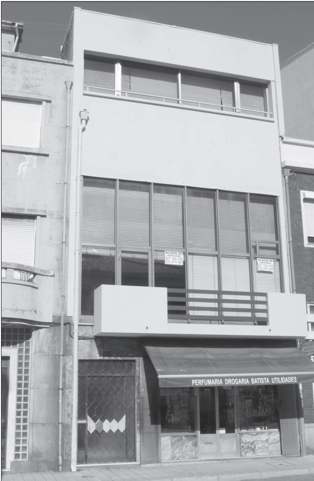
3. Viana de Lima, Casa da Rua Carlos Malheiro Dias (Dom przy ul. Carlos Malheiro Dias, Porto/Portugalia), 1941-1942, stan obecny. Przekształcenia: zamknięcie przestrzeni w układzie wejścia oraz przy ogrodzie górnego balkonu. Oryginalne pozostały elementy konstrukcyjne i materiały 3. Viana de Lima, Casa da Rua Carlos Malheiro Dias (House in Carlos Malheiro Dias St., Porto/Portugal), 1941-42. Changes: closing of the entrance area and next to the garden of the upper balcony. The original structural elements and materials
