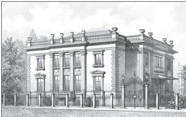
4. Willa Heinauer w Berlinie, „Architektonisches Skizzenbuch”, Jahrgang 1877, Heft IV, Blatt 4 4. Heinauer Villa in Berlin, „Architektonisches Skizzenbuch”, Jahrgang 1877, Heft IV, Blatt 4
