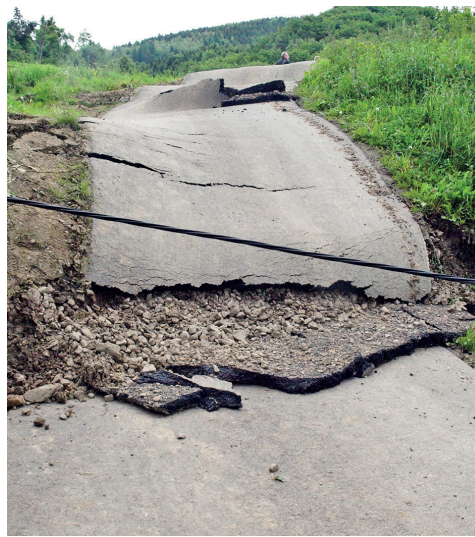
Zniszczenia spowodowane przez osuwisko w miejscowości Kłodne, gmina Limanowa
