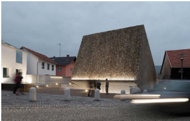
Il. 2. Blaibach (Bawaria), sala koncertowa w centrum małej miejscowości (arch. Peter Heimler, 2014). Po lewej urząd gminy, z prawej stodoła Waidlerów (fot. NAARO https://www.archdaily.com/photographer/naaro ).
