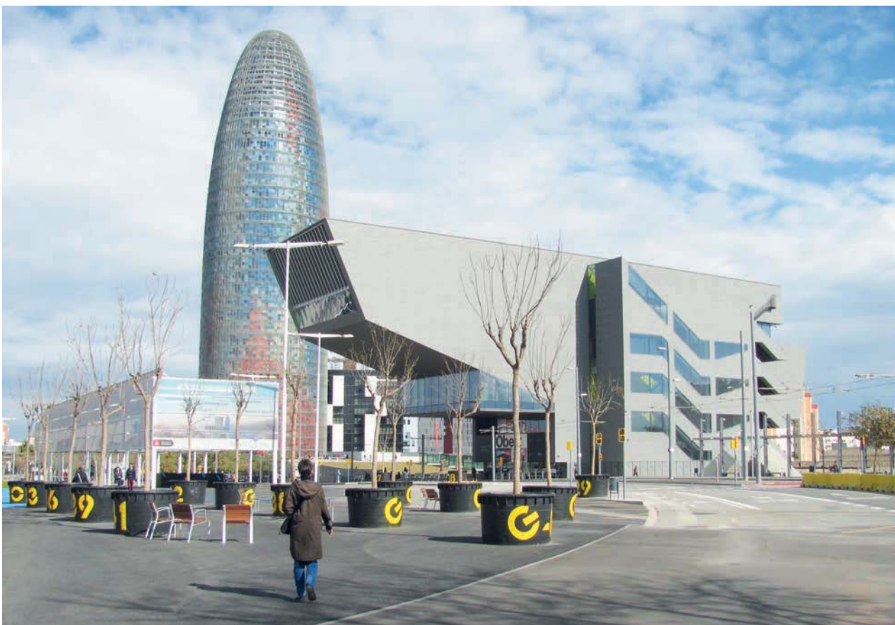
II. 10. Charakterystyczna forma wieżowca wraz z obiektem Muzeum Designu stanowią oprawę przebudowanego Pląca Glories – fot. autor
