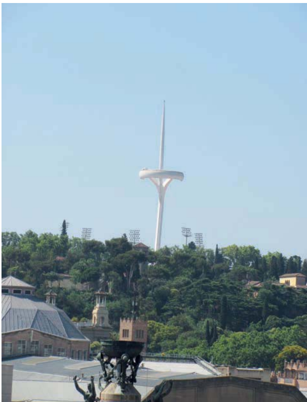
Il. 15. Delikatna, biała rzeźbiarska forma wieży telekomunikacyjnej na Montjuïc zdaje się dematerializować na tle nieba – fot. autor
