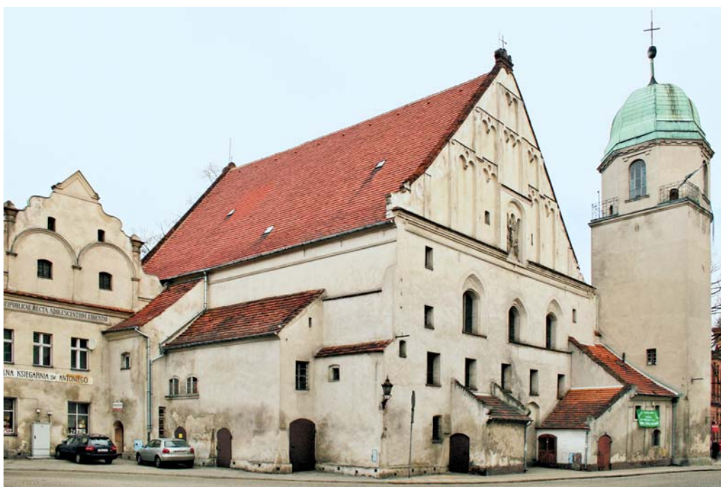
15. Wschowa (m. pow., woj. lubuskie), dawny staromiejski kościół ewangelicko-luterański im. Żłóbka Chrystusa ( Kripplein Christi ), zbudowany 1604, przebudowany po 1644 i po 1685. Od 1945 nieużytkowany, własność miasta i gminy Wschowa. Widok ogólny od południowego wschodu. Fot. M. Ławrynowicz
