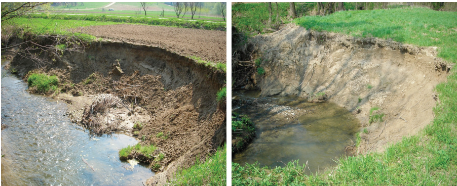
Fot. 1. Osuwiska spowodowane przez wodę wpływającą do nor bobrowych podczas przyboru wiosennego w miejscowości Błażowa
