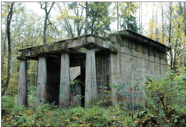
6. Brzeg Dolny, ruiny mauzoleum Hoymów.
